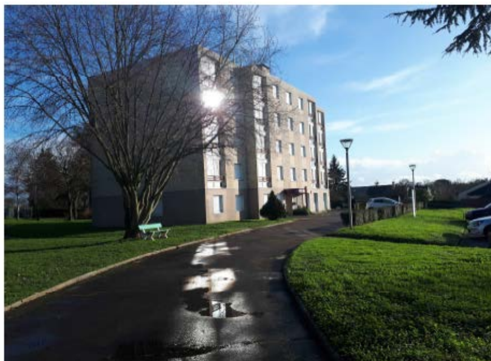
Photo actuelle du foyer logement « La Piscine »
