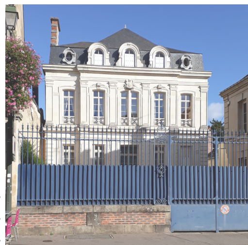
Portail et grille avec tôle festonnée
