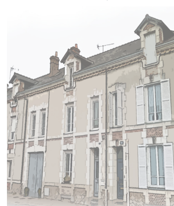
Appareillage pierre et remplissage brique
