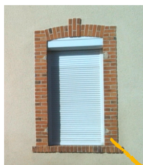
Coffre de volet roulant extérieur sur un linteau cintré
