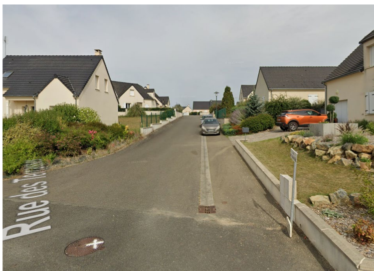
Rue des terrasses : du n°9 au n°19 et du n°28 au 32
